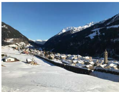
Il muraglione che protegge l'abitato di Airolo
