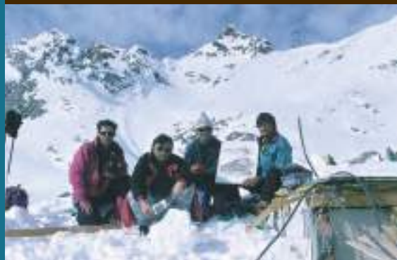
Primi sopralluoghi alla Capanna Cristallina completamente distrutta dalla valanga del 26.2.1999.
